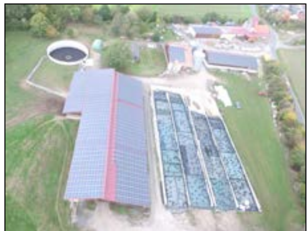
Kennzahlen der neuen Photovoltaikanlage: Installierte Leistung: 499 kWp Prognostizierte Stromerzeugung: 380.000 kWh/a Fläche: 2.600 qm
