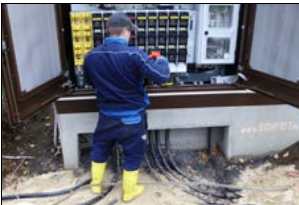
Sebastian Koch bei der Installation der Trafostation Raiffeisen in Wernswig. Foto: kbg
